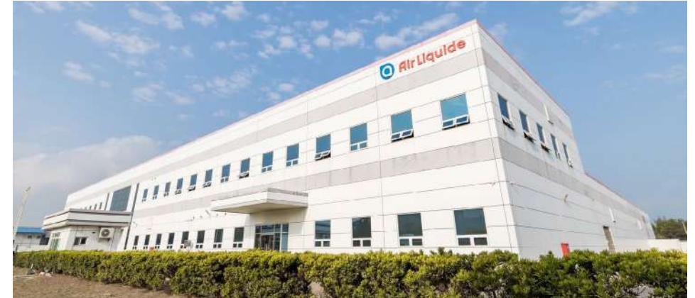
Photo : Air Liquide
