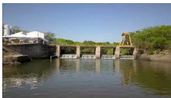
Station de traitement d'eau potable Las Pavas
