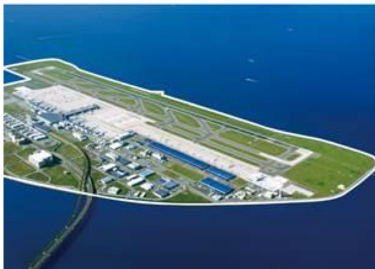
Figure 9 : Aéroport international de Chubu. Source : JHSBA.
